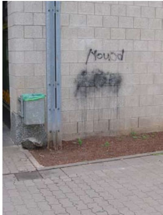
Einkaufszentrum am See: Aussenfassade zum Parkplatz hin
