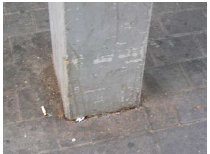
Einkaufszentrum am See: Stütze im Innenbereich des Zentrums
